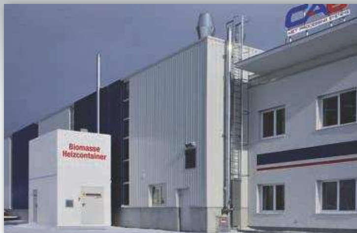
Container double pour le chauffage d'une entreprise.
