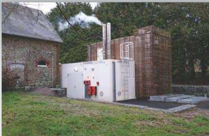
Container simple pour une maison individuelle
